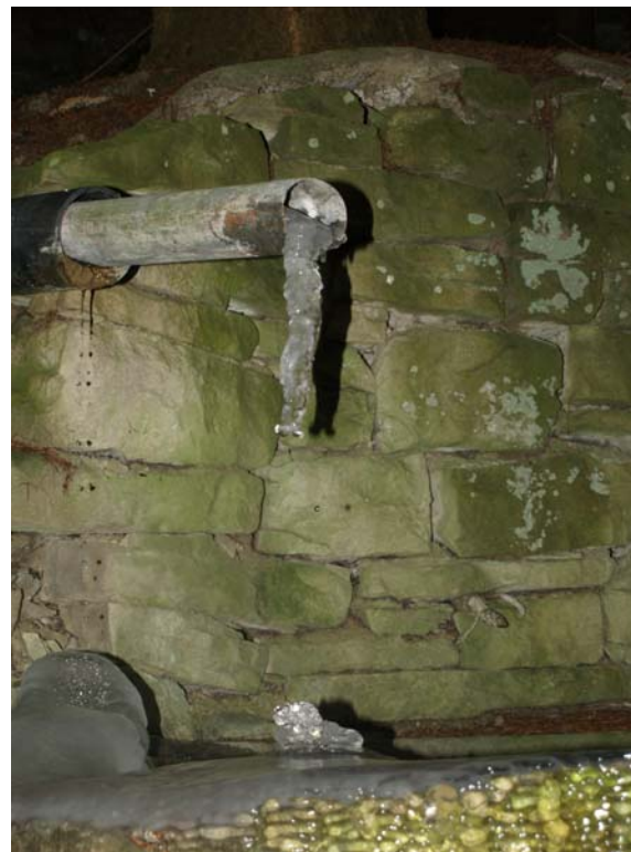
Die vereiste Brunnenanlage, erbaut für die frühere Aufbereitung der Spritzmittel.
