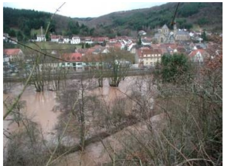
Land unter ( Der Bahndamm schützt den Ortskern vor der Überflutung. )
