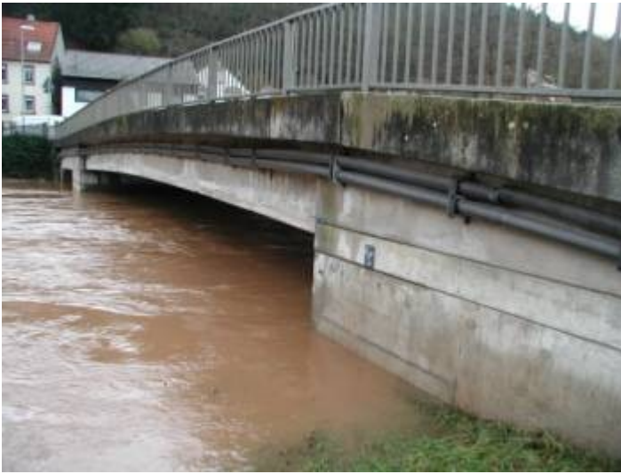
Glanbrücke in Offenbach am 03.01.03 gegen 16.00 Uhr. ( Die obere Markierung an der Brückenmauer gibt den bisher dort gemessenen Höchststand vom 21.12.93 an, vgl. Bild rechts)
